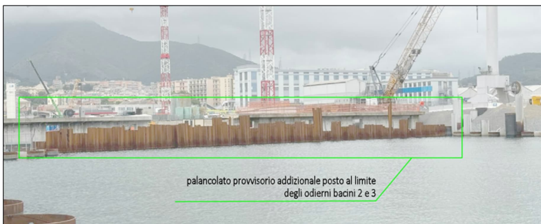
Figura 4.2: Palancolato metallico provvisorio.
